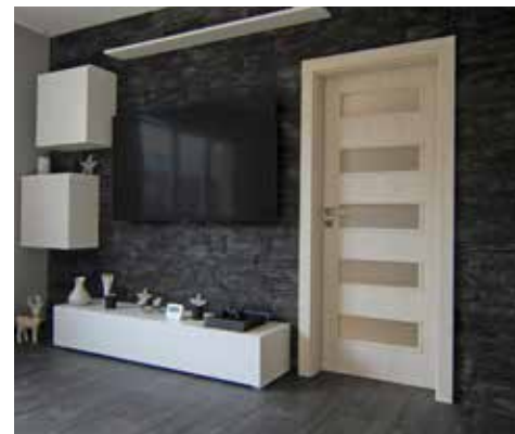
obklad kovové zárubně s novými dveřmi
